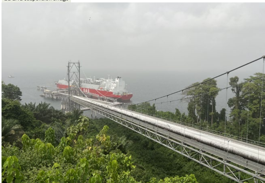
EG LNG suspension bridge
